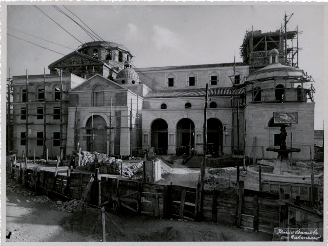
11.4.6. Ricostruzione del duomo di Catanzaro, prospetto laterale, foto d'epoca del cantiere.
