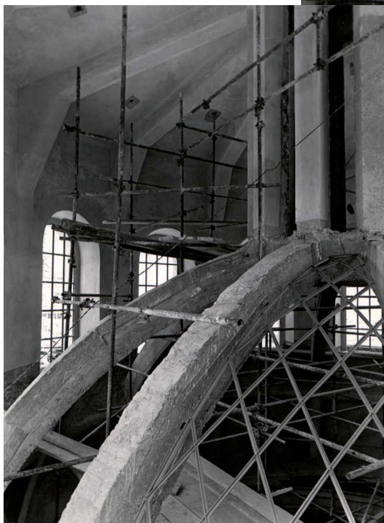
11.4.7., 11.4.8. Ricostruzione del duomo di Catanzaro, dettagli della costruzione della cupola, foto d'epoca del cantiere.
