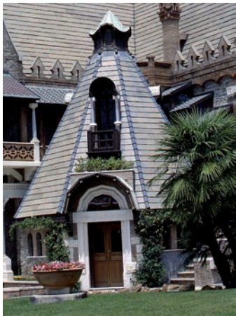
11. La Casina delle Civette, particolare del corpo ottagonale sopraelevato.
