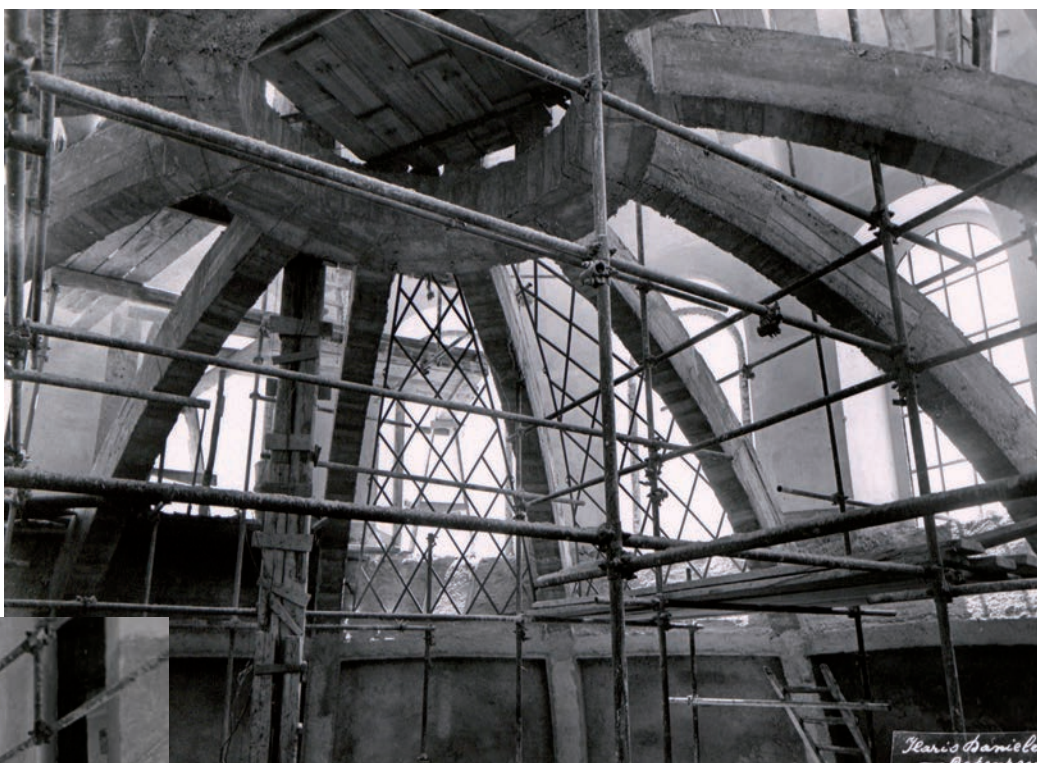
11.4.7., 11.4.8. Ricostruzione del duomo di Catanzaro, dettagli della costruzione della cupola, foto d'epoca del cantiere.
